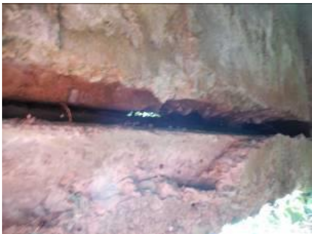
Spára mezi deskou a okrajem NK na výtoku
