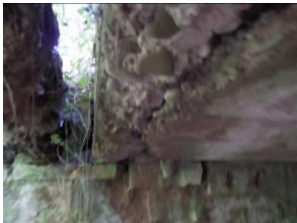
Spára mezi deskou a okrajem NK na vtoku
